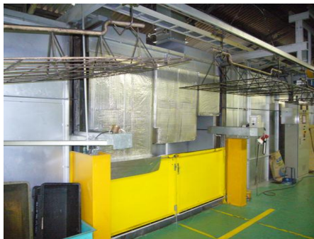
<コーティング炉耐寒対策実施中>
