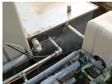
＜配管の漏水チェック＞
