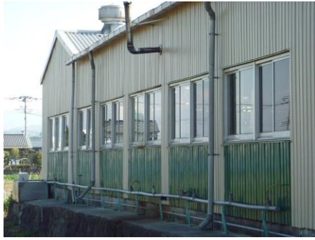
<工場西側外壁の劣化防止・美化>
