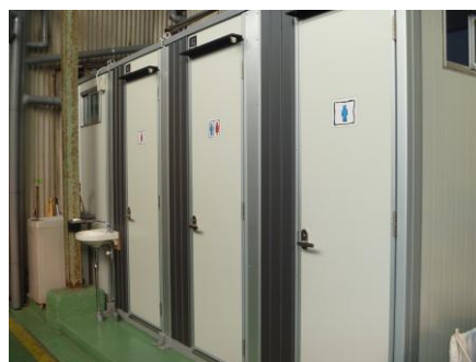
<工場内トイレの改修工事>
