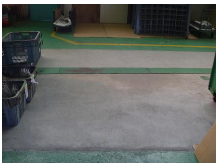
<工場内の床補修>
